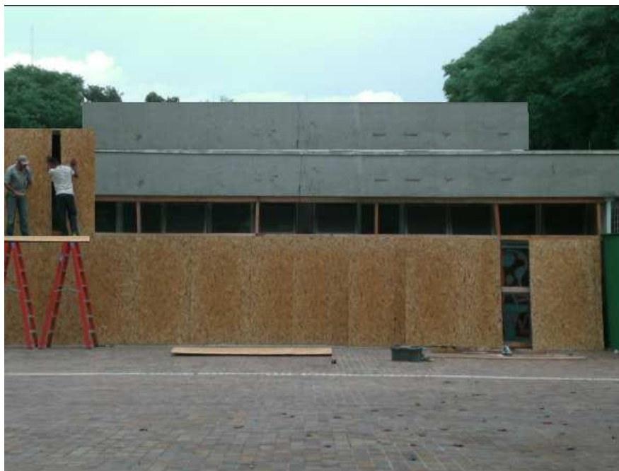
Execução de colocação de tapumes na loja de material de construção “Construindo com Eficiência” – Centro
